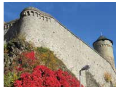
5/ Bauhistorisch detailliert untersucht wurden die Südwingermauer und der Turm mit Verlies.
